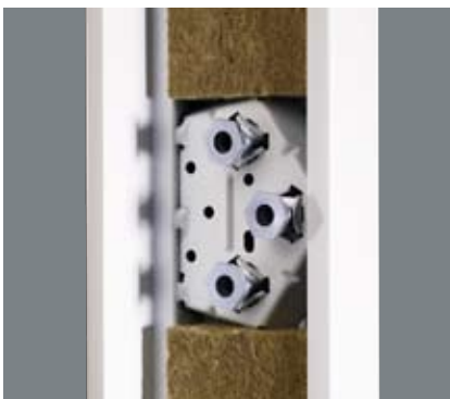
Tre infästningspunkter vid varje gångjärn ger ökad stabilitet. Karmhylsor underlättar snabbt och säkert montage.
