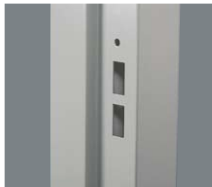
Slutbleck med säkerhetsbult.
