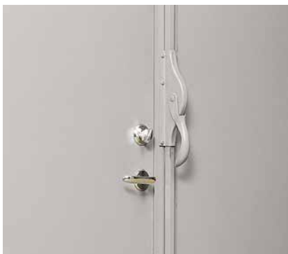
Spanjolett är standard på parhalvan. Rostfria portar förses med kantregel i rostfritt material.
