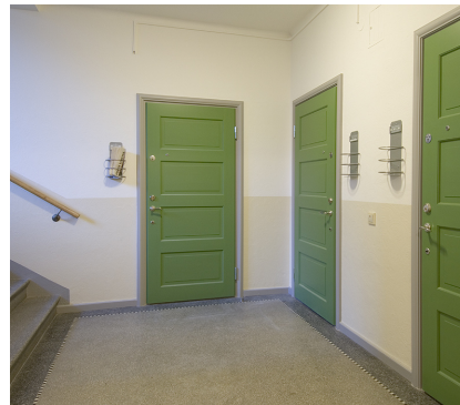
Säkerhetsdörrar typ D43 i renoverat trapphus
