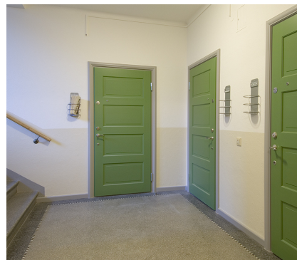
Säkerhetsdörrar typ D43 i renoverat trapphus
