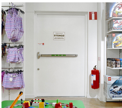
Säkerhetsdörr med panikregel, magnetkontakt och mikrobytare i lås är en vanlig syn i butiker
