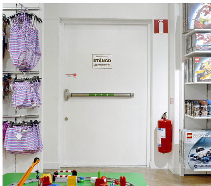
Säkerhetsdörr med panikregel, magnetkontakt och mikrobytare i lås är en vanlig syn i butiker
