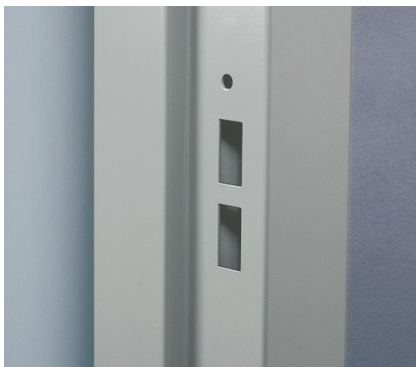
Slutbleck med säkerhetsbult.
