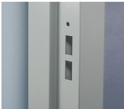
Slutbleck med säkerhetsbult.
