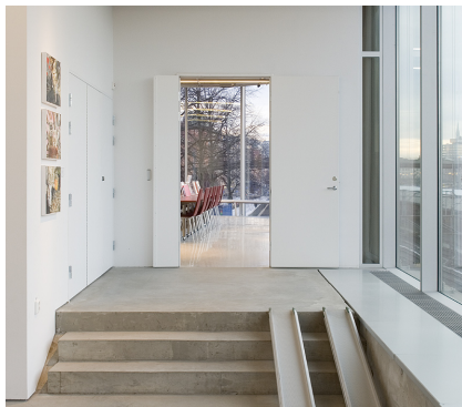
Massivdörr i pardörrsutförande till konferensrum
